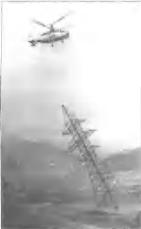
Установка опоры ЛЭП с помощью Ка-32.
